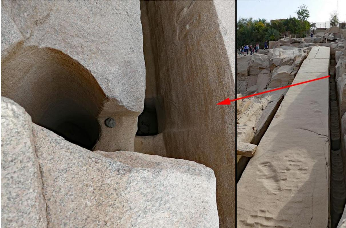
Bild 6: Herstellung der Rinnen unter dem Stein.
